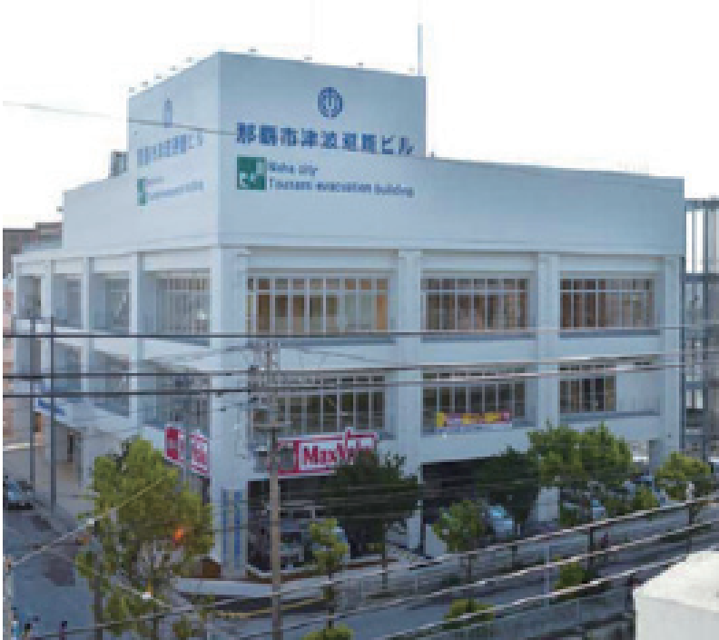
那覇市津波避難ビル（那覇市松山 2-22-1）
